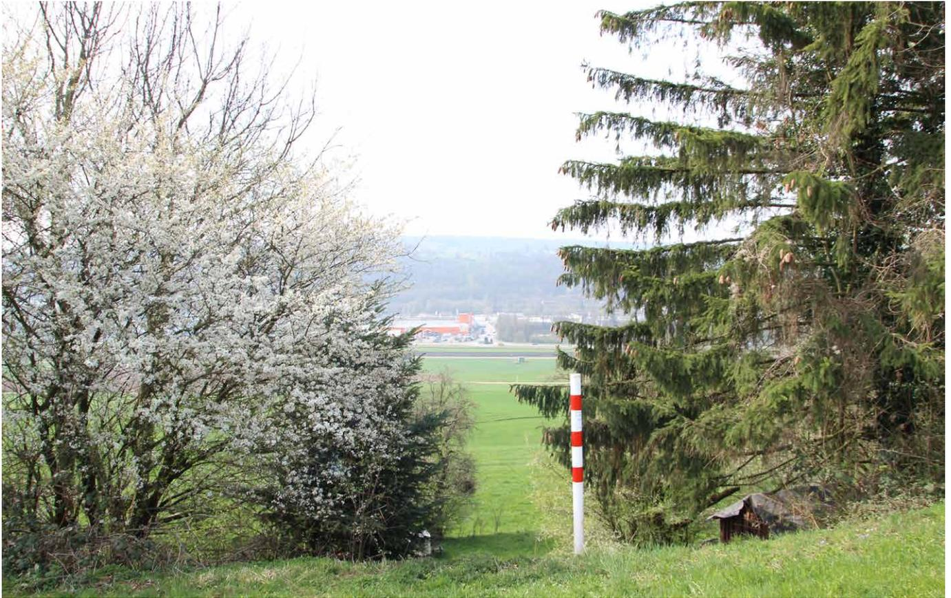
Die Pipeline wird regelmäßig überflogen, um Änderungen in der Erdoberfläche zu erkennen. Sie darf deshalb nach rechts und links je drei Meter nicht mit Bäumen etc. bewachsen sein. Dadurch entstehen Schneisen, an denen man besonders im Winter ihren Verlauf auch auf längere Strecken ersehen kann.
